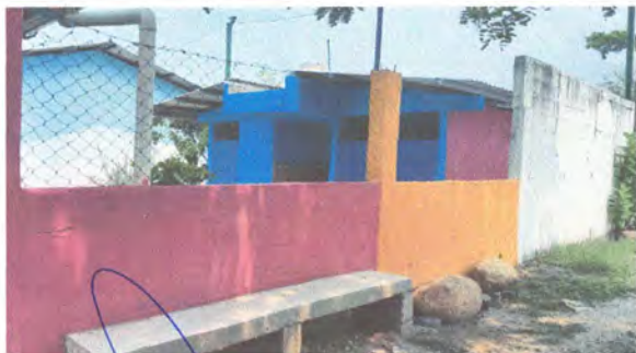
9.1 Baranda sobre muro perimetral ✓
