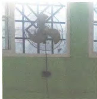
7.1 Sustitución de ventiladores en modulo de aula #2 ✓
