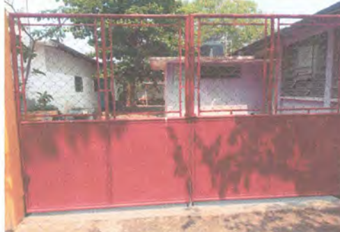
8.1 Mantenimiento a portón de metal ✓
