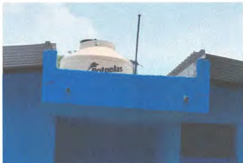
11.1 Sustitución de accesorios de deposito de agua
