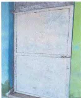
3.1 Mantenimiento a puertas de metal
