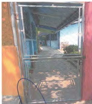
3.3 Sustitución de puerta de ingreso
