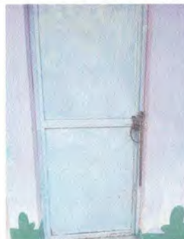
3.2 Sustitución de puerta a servicio sanitario
