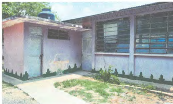
6.1 Pintura a muros interiores y exteriores ✓
