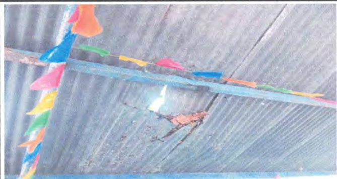
1.1 Sustitución de lamina por lamina troquelada aluzinc
