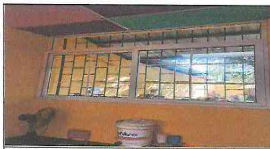
Foto 5: Sustrucción de ventanales de metal por ventanas de PVC.
