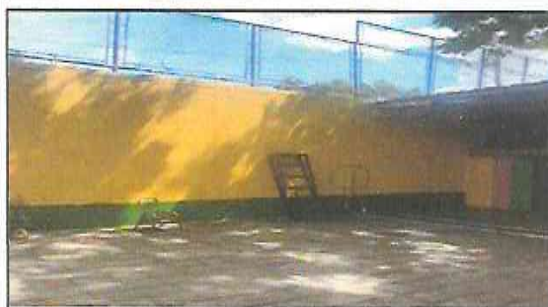
Foto 3: pintura de Paredes.
