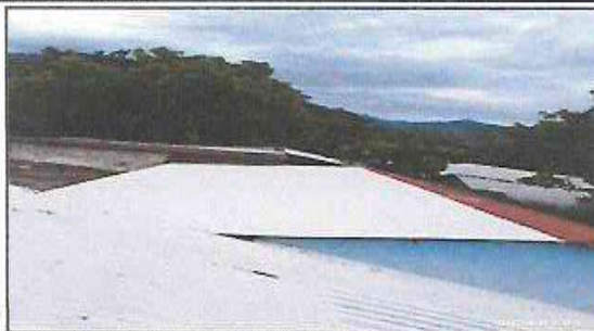
Foto 1: Sustrucción de láminas de techo.
