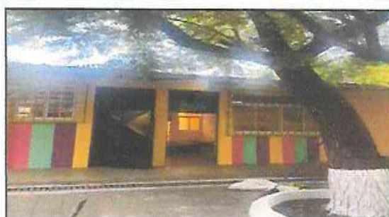
Foto 4: Reparación y nivelado de adoquín.
