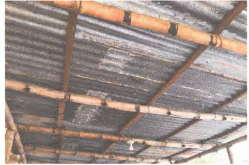
8.1 Sustitución de estructura de madera por metal
