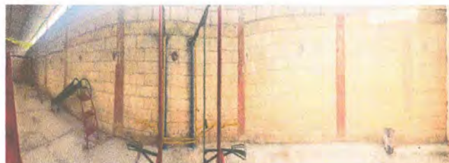
5.1 Repello de muro perimetral
