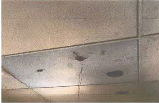
7.1 Sustitución de cielo falso
