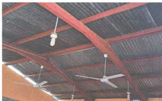
1.2 Sustitución de ventiladores aula 1,2,3
