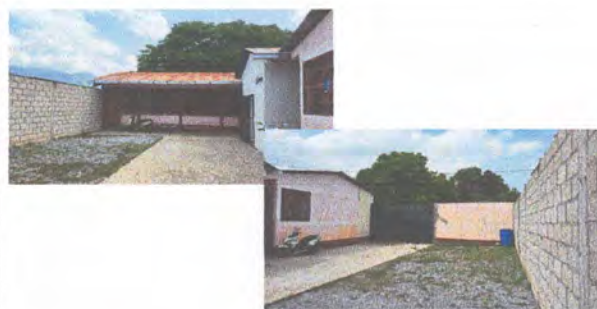
3.1 Pintura en muros exteriores e interiores
