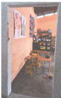
1.1 Instalación de puerta en aula 3 1.80 x 1.10mt
