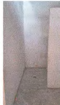
4.4 Instalación de puerta en servicio sanitario 0.80 x 1.60mt
