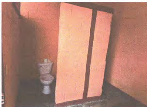
4.3 Instalación de puertas en servicios sanitario 0.70 x 1.60 mt
