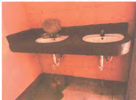
4.2 Sustitución de lavamanos por pileta fundida con azulejo
