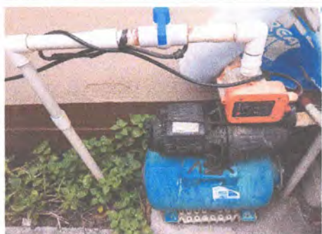
2.1 Sustitución de equipo hidroneumático de 1/2HP de 24 Lts.
