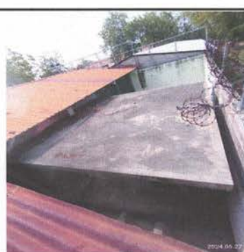
3.5 SUSTITUCION DE LAMINAS DE TECHO
