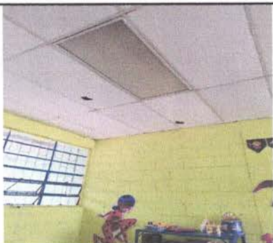
2.2 REPARACIÓN CIELO FALSO
