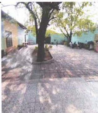
1.2 REPARACIÓN Y NIVELADO DE ADOQUIN
