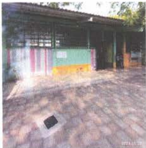
1.1 SUSTITUCIÓN DE CANAL DE CONCRETO
