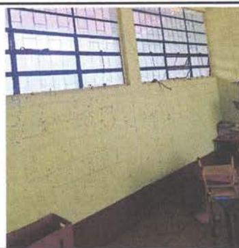
2.1 PINTURA DE PAREDES
