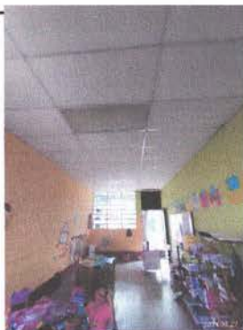
3.1 PINTURA DE PAREDES
