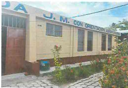
Foto 3: REMOZAMIENTO DE MURO DEL MÓDULO ADMINISTRATIVO
