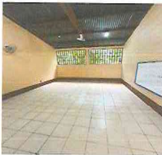
Foto 5: SUSTITUCIÓN DE PISO DE CONCRETO POR PISO CERAMICO
