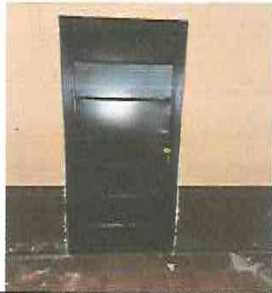
Foto1: SUSTITUCION DE PUERTA DE MADERA POR PUERTA DE METAL
