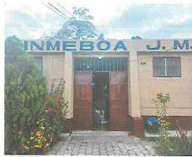
Foto 2: REMOZAMIENTO DE MURO DE MÓDULO ADMINISTRATIVO
