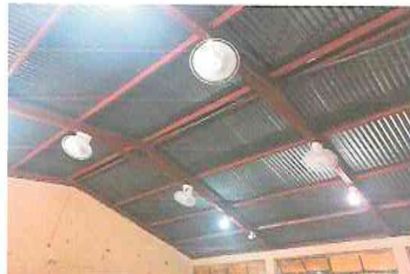
Foto 4: SUSTITUCIÓN DE VENTILADORES EN MAL ESTADO POR VENTILADORES DE TECHO Y PARED
