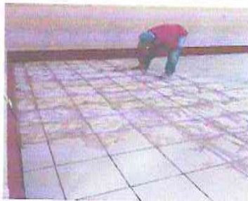
Foto 5: SUSTITUCIÓN DE PISO DE CONCRETO POR PISO CERAMICO
