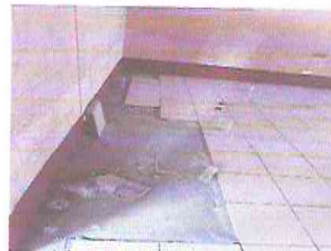
Foto 5: SUSTITUCION DE PISO DE CONCRETO POR PISO CERAMICO
