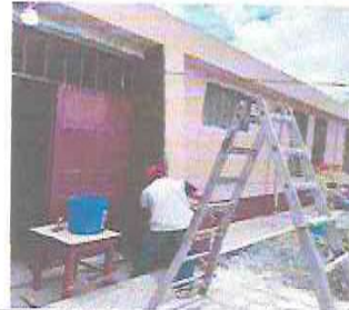
Foto 2: REMOZAMIENTO DE MURO DE MÓDULO ADMINISTRATIVO
