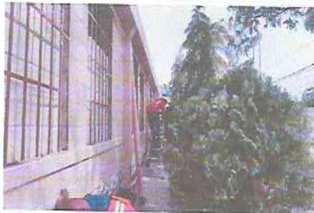
Foto 3: REMOZAMIENTO DE MURO DEL MÓDULO ADMINISTRATIVO
