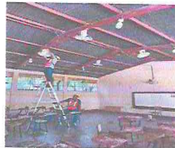
Foto 4: SUSTITUCIÓN DE VENTILADORES EN MAL ESTADO POR VENTILADORES DE TECHO Y PARED
