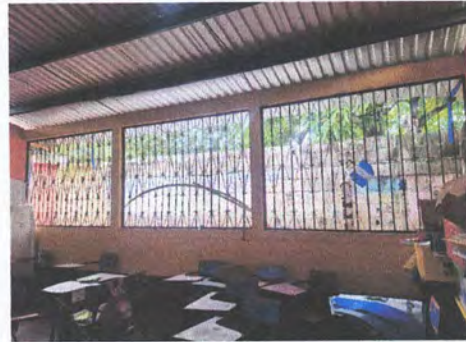
Foto 2: 4.1 INSTALACION DE CIELO FALSO
