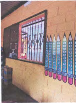
Foto 3 4.2 REPARACION Y PINTURA DE VENTANAS DE METAL
