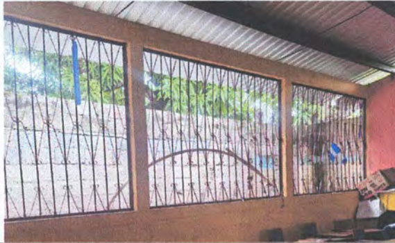
Foto1: 1.1 PINTURA DE MUROS EXTERIORES
