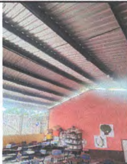
Foto 5: 3.1 INSTALACION DE CIELO FALSO
