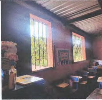
Foto1: 3.3 REPARACION DE VENTANAS DE METAL
