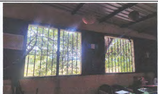
Foto 6: 3.2 SUSTITUCION DE VENTANAS DE METAL POR VENTANAS PVC
