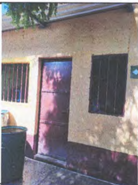
Foto 3: 6.3 MANTENIMIENTO Y REPARACION DE BALCONES DE METAL
