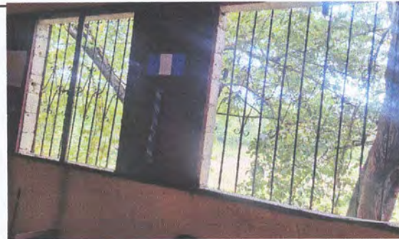
Foto 6: 5.3 MANTENIMIEMTO Y REPARACION DE VENTANAS DE METAL
