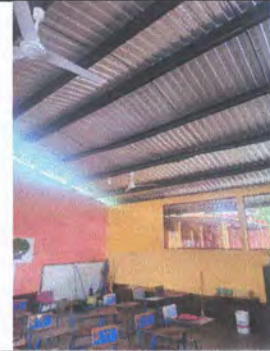
Foto 4: 2.2 INSTALACION DE CIELO FALSO
