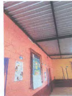
Foto 4: 5.1 INSTALACION DE CIELO FALSO
