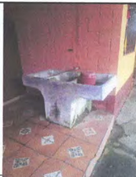
Foto 5: 6.5 SUSTITUCION DE PILA
