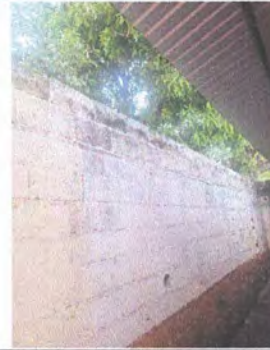
Foto 2: 1.2 INSTALACION DE RAZOR
