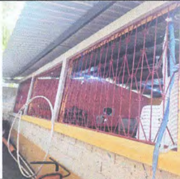
Foto 3: 2.1 SUSTITUCION DE VENTANAS POR VENTANAS PVC
