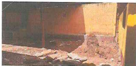
Foto 3: Demolición de concreto en mal estado
