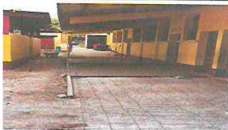
Foto 4: Restructuración de torta losa de concreto
