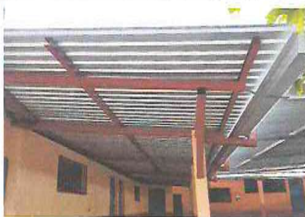
Foto 1: Sustitución de lámina en aulas
