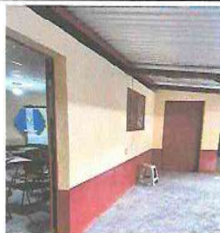
Foto 2: Pintra de estructura metálica
