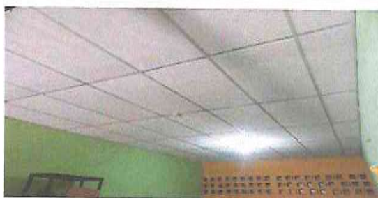
Foto 5: Instalación de cielo falso
