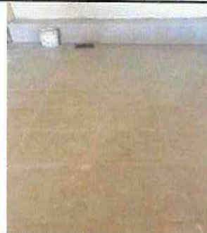
Foto 4: sustitución de piso
