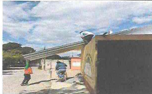
Foto 2: Sustitución de lamina en cocina
