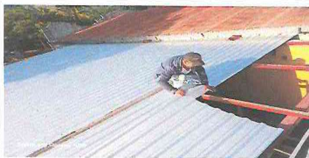
Foto1: Sustitución de lámina en aulas
