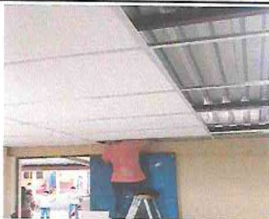
Foto 5: Instalación de cielo falso
