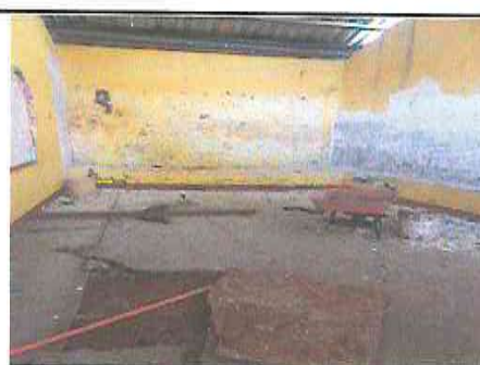
Foto 4: sustitución de piso
