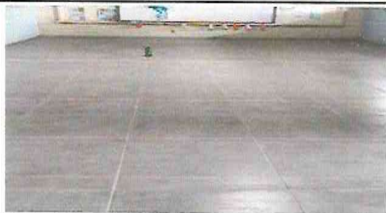
1.5. Puesta de piso cerámico en aulas 1 y 2, y en el área del corredor.
