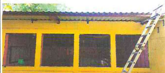
1.2 Parte de enfrente terminada del aula 1
