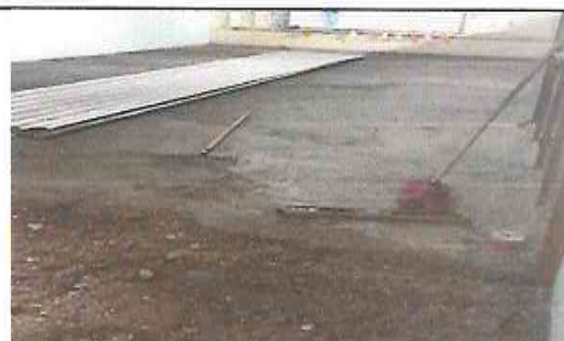
1.4. Puesta de concreto en aulas 1 y 2
