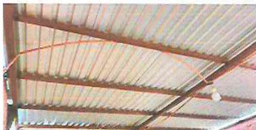
1.1 Puesta completa de lámina y estructura metálica en aula No.1
