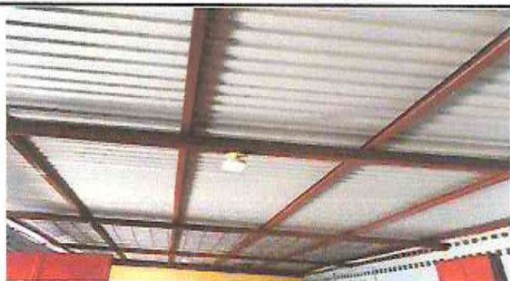
1.3. Puesta de láminas y mantenimiento de estructura metálica en aulas 1 y 2
