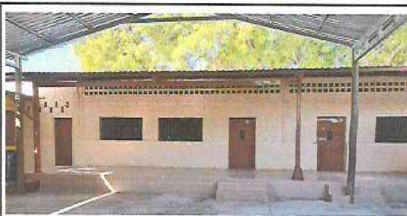
1.6. Parte de enfrente terminada del cambio de piso
