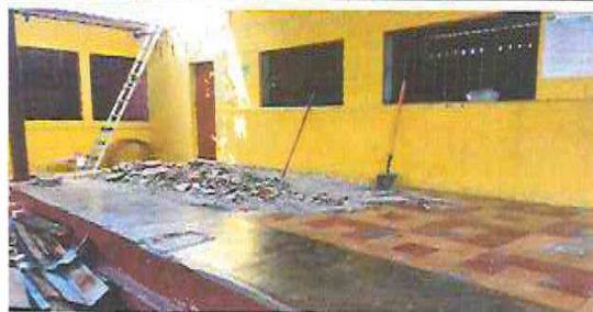
1.5. Retiro de piso en el área del corredor
