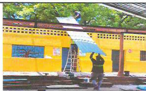
1.4. Colocación de láminas en aulas 1 y 2
