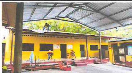
1.2 Retiro de láminas en aulas No. 2 y 3
