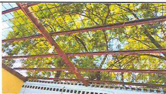
1.3. Mantenimiento de estructura metálica en aulas 1 y 2
