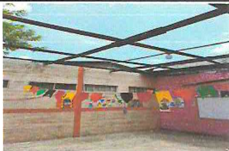
1.1 Retiro de lámina y estructura metálica en aula No.1
