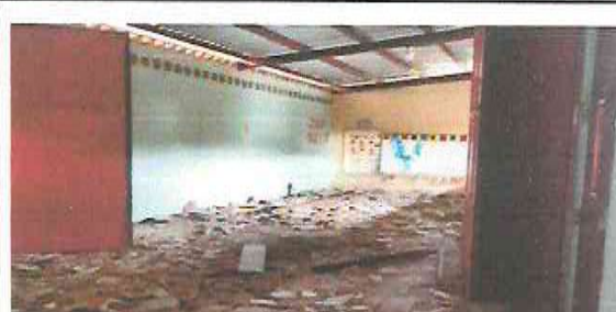
1.6. Retiro de piso en las aulas 1 y 2
