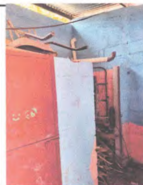
4.5 REPARACION DE PUERTAS DE METAL /
