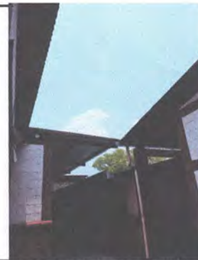
2.1 SUSTITUCION DE ESTRUCTURA METALICA Y LAMINA TROQUELADA ALUZINK
