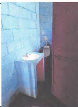
4.4 APLICACIÓN DE PINTURA LAVABLE /
