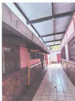
3.1 SUSTITUCION DE CANAL ALUZINK
