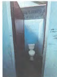
4.1 CAMBIO DE ACCESORIOS DE SANITARIOS
