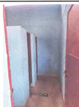
4.3 SUSTITUCION DE PISO DE CONCRETO POR PISO CERAMICO ANTIDESLIZANTE /
