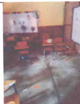
Foto 4: 5.1 SUSTITUCION PISO DE GRANITO
