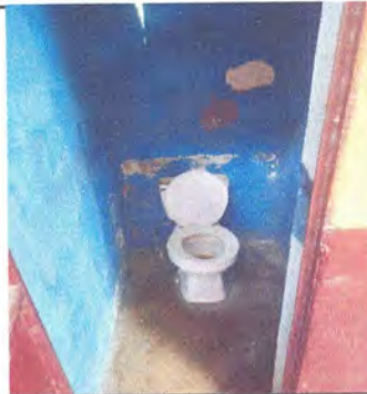
Foto 3: 2.1 SUSTITUCION DE PISO DE CONCRETO POR PISO CERAMICO 2.2 SUMINISTRO E INSTALACION DE CERAMICO EN PAREDES 2.3 SUSTITUCION DE INODOROS
