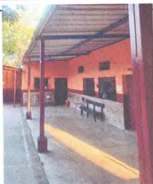
Foto 3: 4.2 MANTENIMIENTO A PUERTAS DE METAL
