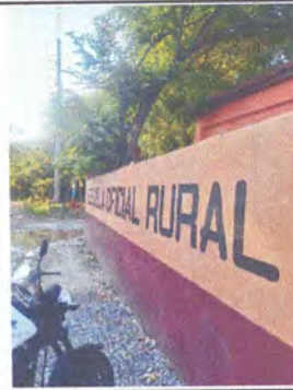
Foto 2: 1.3 PINTURA GENERAL EN MURO PERIMETRAL
