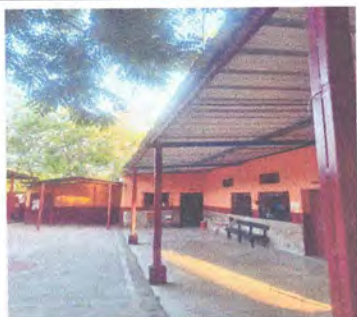
Foto 5: 5.2 SUSTITUCION DE CANAL
