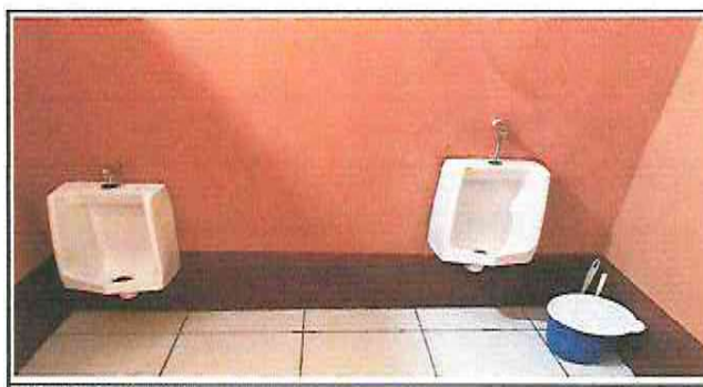
Foto 6: Reparación de sanitarios
