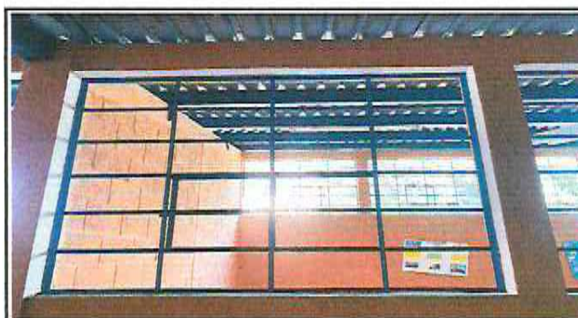
Foto 4: Mantenimiento de balcones
