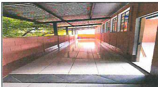
Foto 3: Instalación de piso
