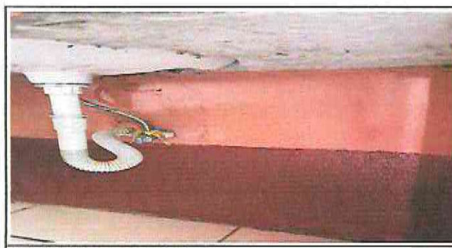
Foto 5: Reparación de lavatrastos
