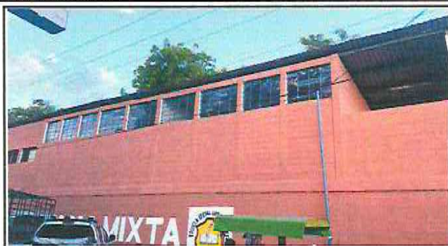
Foto1: Aplicación de pintura en muros
