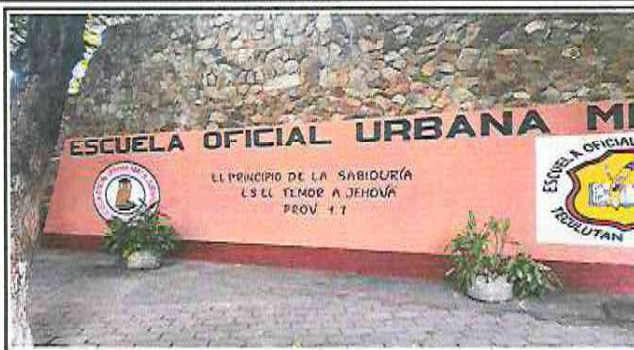
Foto 2: Aplicación de pintura en muros
