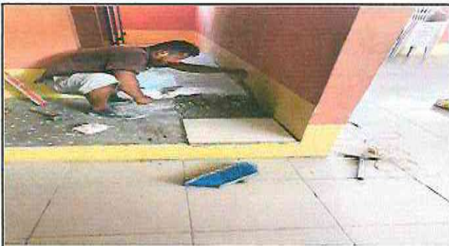
Foto 3: Instalación de piso
