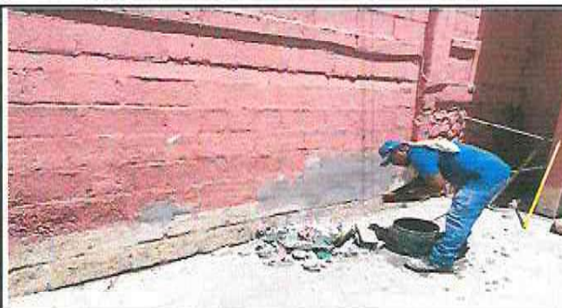
Foto 2: Aplicación de pintura en muros
