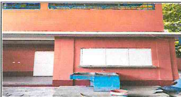
Foto 5: Reinstalación de pila
