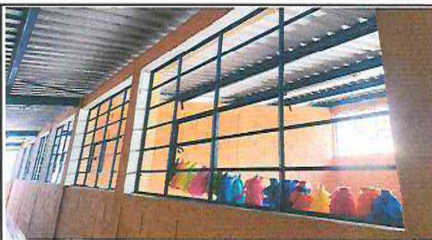
Foto 4: Mantenimiento de balcones
