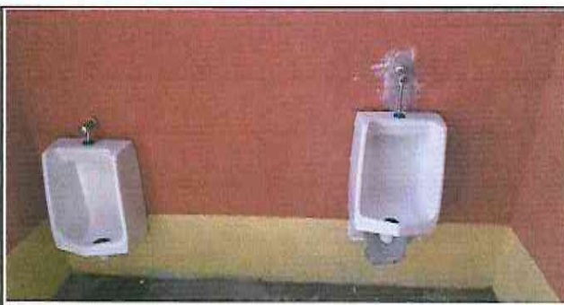
Foto 6: Reparación de sanitarios
