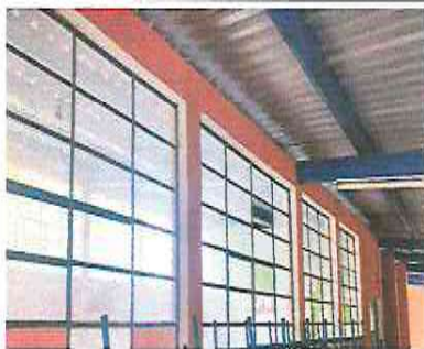
Foto 11: Mantenimiento de balcones de metal
