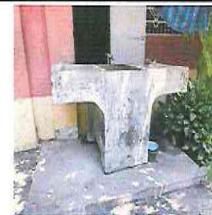
Foto 12: Cambio de posición de pila + caja + tubería PVC
