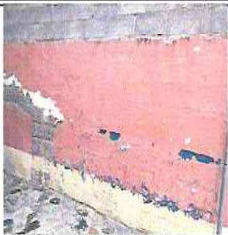
Foto 7: Aplicación de pintura en muros
