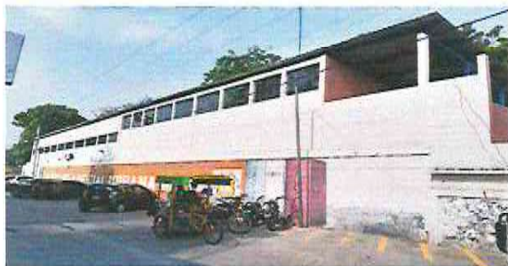
Foto 9: Aplicación de pintura en muros exteriores
