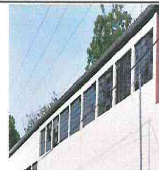
Foto 10: Mantenimiento de balcones de metal
