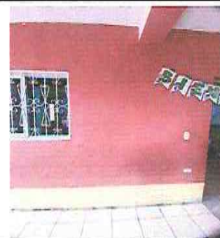
Foto 8: Aplicación de pintura en muros
