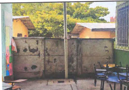
Foto 3: SUSTITUCION DE TAPIAL PREFABRICADO A BLOCK
