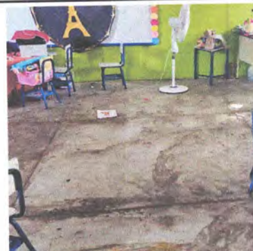
Foto 4: SUSTITUCION DE PISO DE CONCRETO
