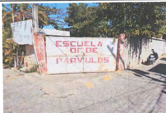
Foto 6: REPARACION DE PORTON METALICO
