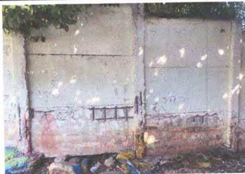
Foto 8: SUSTITUCION DE TAPIAL PREFABRICADO A BLOCK
