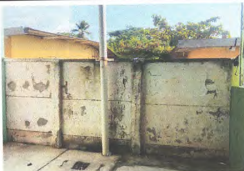
Foto 9: SUSTITUCION DE TAPIAL PREFABRICADO A BLOCK
