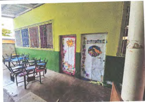
Foto 1: REPARACION DE PUERTAS DE METAL
