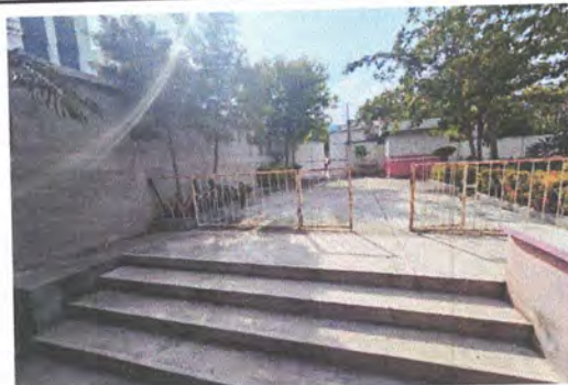
Foto 2: SUSTITUCION DE BARANDAS
