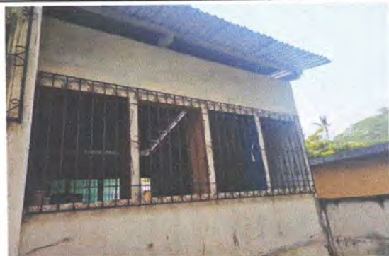
Foto 5: PINTURA EN MUROS EXTERIORES E INTERIORES
