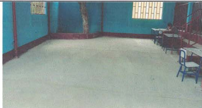
Instalación de piso antideslizante y sócalo en patio
