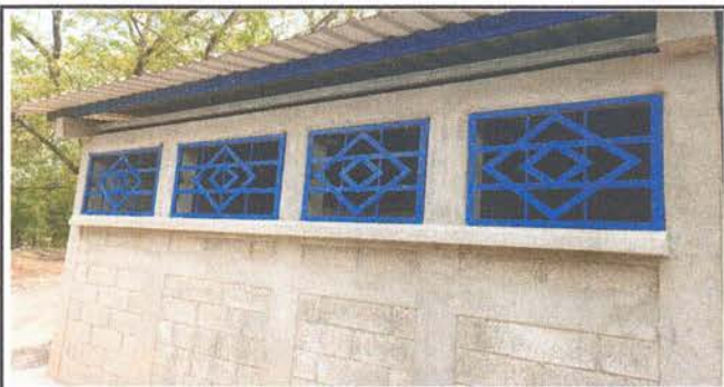
INSTALACION DE 4 MOSQUITEROS SOBRE BALCONES LADO EXTERIOR DE AREA DE BAÑOS, ESTO PORQUE PERSONAS INESCRUPULOSAS TIRARON BOMBAS PARA ADETRÁS DEL AULA Y ROMPIERON UN LAVAMANOS QUE TAMBIEN SE SUSTITUIRÁ
