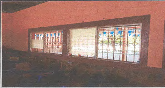
SUMINISTRO E INSTALACION DE VENTANAS PVC COLOR BLANCO, CON REJILLA Y MOSQUITERO, EN AREA DE AULAS
