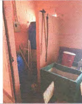
REMOSION DE PARED DE 2 X 1 M2 EN DONDE SE INSTALARA LA PILA PREFABRICADA EXISTENTE QUE SE MUESTRA EN LA FOTO AREA DIRECCION
