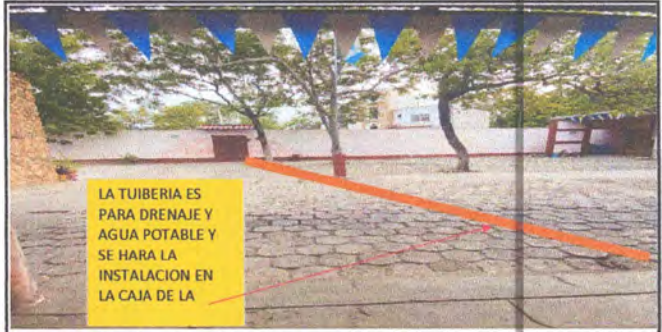
SUMINISTRO E INSTALACION DE TUBERIA DE PVC PARA AGUAS NEGRAS, PARA AREA DE DIRECCION DONDE ACOMODARAN COCINA PARA PREPARAR ALIMENTACION ESCOLAR
