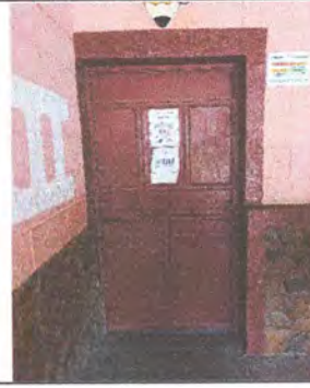
SUMINISTRO E INSTALACION DE CHAPA DE BUENA CALIDAD EN PUERTA AREA DIRECCION
