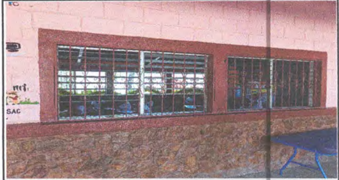
SUMINISTRO E INSTALACION DE VENTANAS PVC COLOR BLANCO, CON REJILLA Y MOSQUITERO, EN AREA DE AULAS
