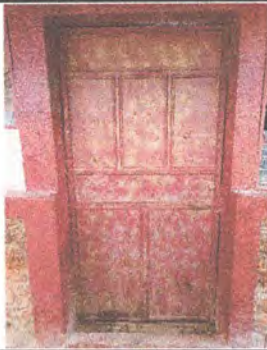
MANTENIMIENTO A PUERTAS DE METAL ( LIJADO Y PINTADO Y REPARACION EN LA PARTE DE ABAJO) AREA DIRECCION
