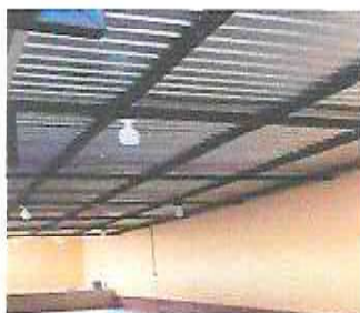
FOTO 7: INSTALACIÓN DE LUMINARIAS, TOMAFUERZA E INTERRUPTOR EN GALERA DE PATIO
