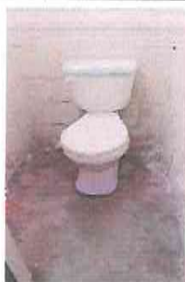
Foto 5: SUSTITUCIÓN DE INODORO EN BAÑOS
