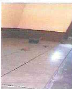
Foto 3: DEMOLICION DE ESTRUCTURA EXISTENTE
