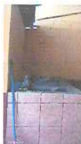
Foto 2: INSTALACIÓN DE AZULEJO DE PILA EN COCINA
