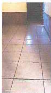
Foto 1: INSTALACIÓN DE PISO MATE EN COCINA
