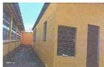
FOTO 8: PINTURA DE MURO EN MURO PERIMETRAL
