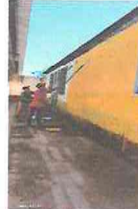
FOTO 8: PINTURA DE MURO EN MURO PERIMETRAL
