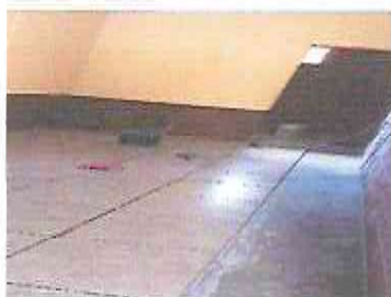
Foto 1: INSTALACIÓN DE PISO MATE EN COCINA
