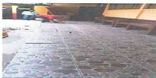
Foto 4: INSTALACIÓN DE PISO ANTIDESLIZANTE EN PATIO
