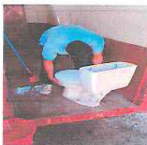
Foto 5: SUSTITUCIÓN DE INODORO EN BAÑOS
