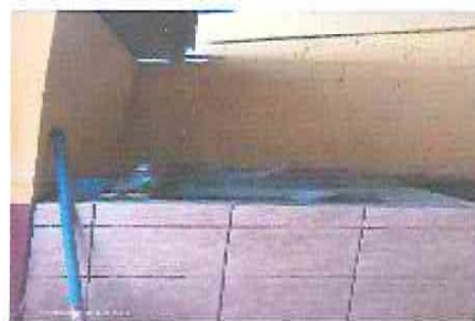
Foto 2: INSTALACIÓN DE AZULEJO DE PILA EN COCINA
