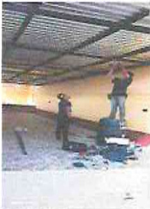
FOTO 7: INSTALACIÓN DE LUMINARIAS, TOMAFUERZA E INTERRUPTOR EN GALERA DE PATIO
