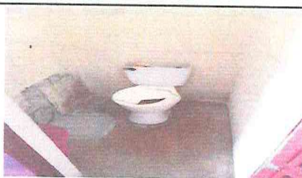
Foto 5: SUSTITUCIÓN DE INODOROS EN BAÑOS.
