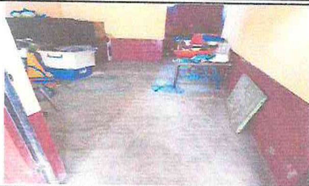
Foto1: INSTALACIÓN DE PISO MATE EN COCINA.
