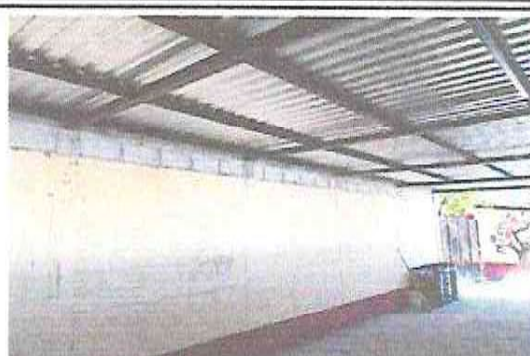
Foto 8: PINTURA DE MUROS EN MURO PERIMETRA.
