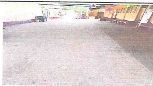
Foto 4: INSTALACIÓN DE PISO ANTIDESLIZANTE EN PATIO.
