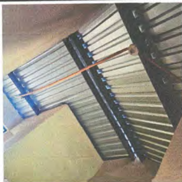
Foto 5: Reparación de Cableado eléctrico .
