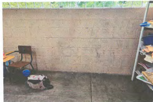
Foto 2: Pintado en Muros interiores
