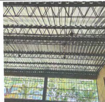
Foto 4: Reparación de Cableado eléctrico .
