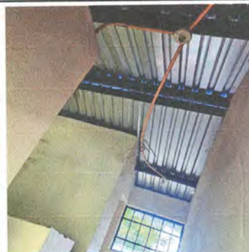
Foto 6: Reparación de Cableado eléctrico .
