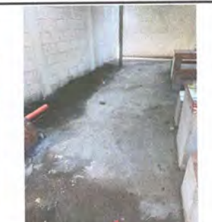
Foto 5: MODULO 3 COMEDOR, SUSTITUCIÓN DE TORTA DE CONCRETO POR BALDOSA DE CONCRETO
