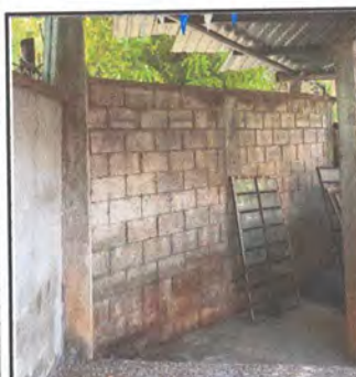
Foto 3: MODULO 1 MURO PERIMETRAL REPELLO A PARED
