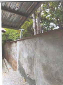
Foto 1: MODULO 1 MURO PERIMETRAL, LEVANTADO DE 2 HILADAS DE BLOCK
