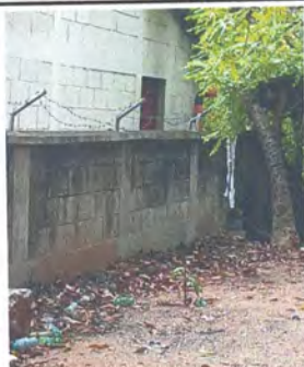
Foto 1: MODULO 1 MURO PERIMETRAL, LEVANTADO DE 2 HILADAS DE BLOCK
