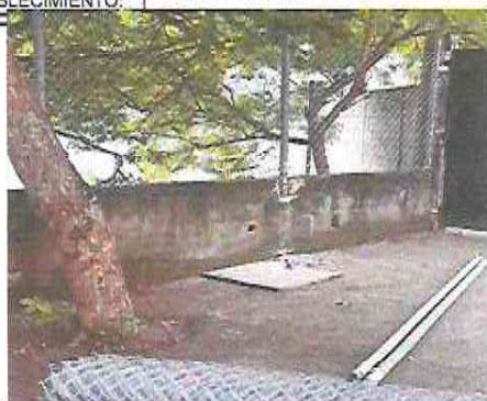
5.1 INSTALACION DE MALLA METALICA CON TUBO GALVANIZADO
