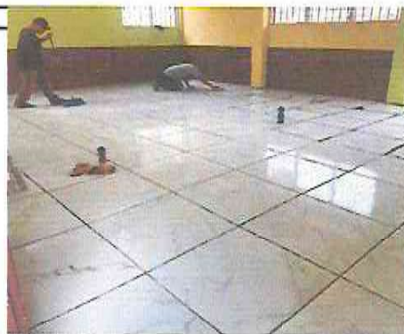
3.1 SUSTITUCION DE PISO
