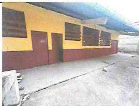
2.1 SUSTITUCION DE CANAL
