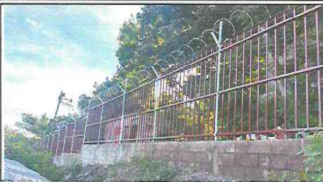
1.1 SUSTITUCION DE MALLA POR BARANDA METALICA
