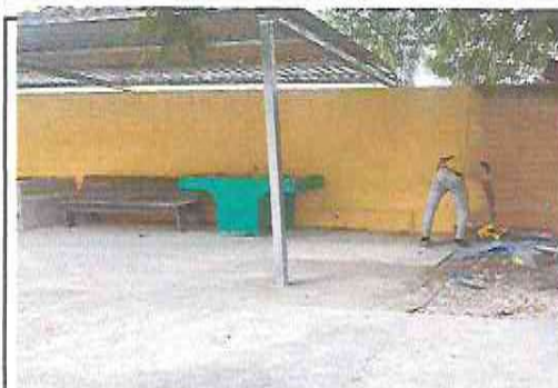
4.3 SUSTITUCION DE PILA
