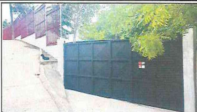
1.2 SUSTITUCION DE PORTON
