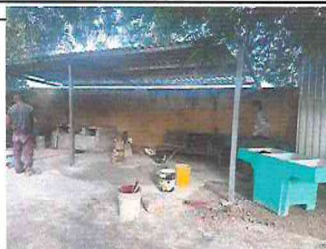
4.3 SUSTITUCION DE PILA
