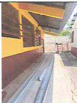
1.1 SUSTITUCION DE MALLA POR BARANDA METALICA
