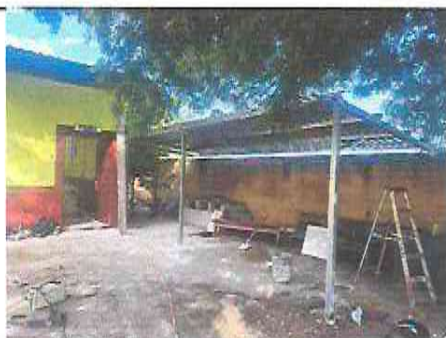
4.1 SUSTITUCION DE ESTRUCTURA METALICA 4.2 INSTALACION DE LAMINA
