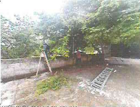
5.1 SUSTITUCIÓN DE MALLA METÁLICA
