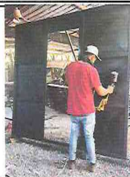
1.2 SUSTITUCION DE PORTON
