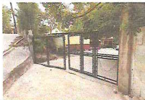
1.2 SUSTITUCION DE PORTON DE METAL
