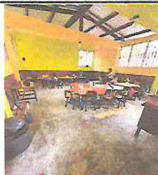
3.1 SUSTITUCION DE PISO DE CONCRETO
