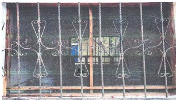
Foto 3: Sustrución de balcones de metal
