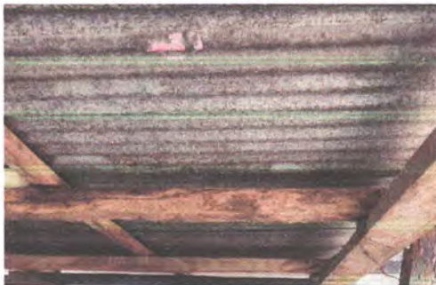
Foto 3: Sustitución de estructura de soporte de madera por metal
