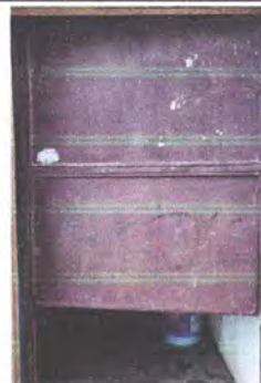
Foto 4: Sustrución de puerta de metal
