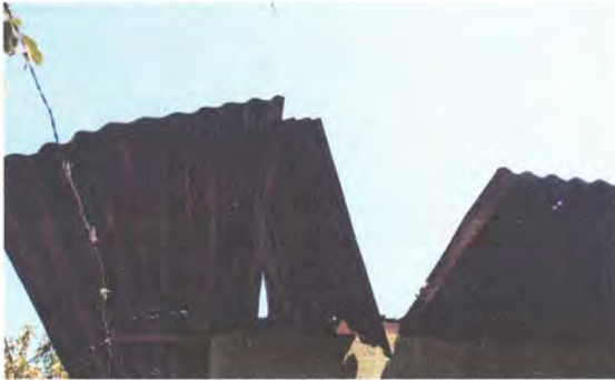
Foto1: Sustitución de lámina por lámina troquelada calibre 256
