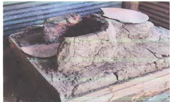
Foto 4: Sustitución de estufa rural completa (Incluye polletón, Plancha metálica y chimenea)
