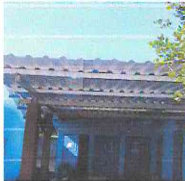
Foto 2 : Ampliación de estructura de techo de cocina con galera adjunta
