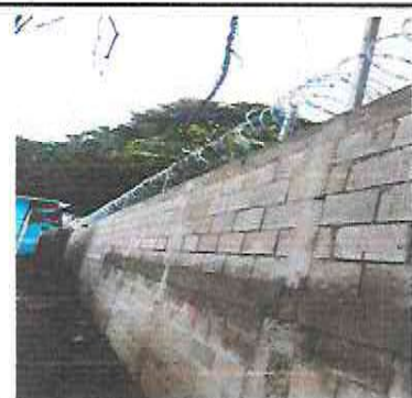
Foto 8 : Instalación de concertina y picos de seguridad en muro perimetral
