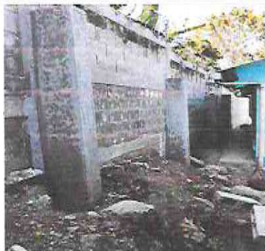
Foto 1 : Sustrucción de muro perimetral de block
