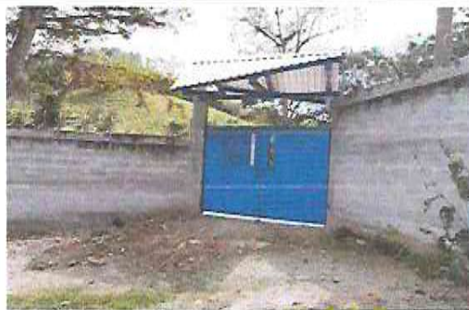
Foto 4 : Mantenimiento a estructura de portón de metal de entrada principal
