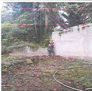
Foto 9: Sustitución de muro perimetral de block
