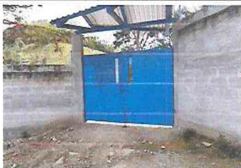
Foto 5 : Mantenimiento a estructura de portón de metal de entrada principal
