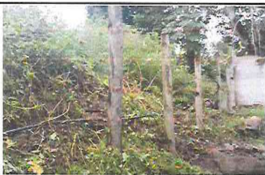
Foto 11 : Sustitución de muro perimetral de block
