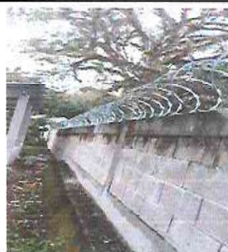
Foto 7 : Instalación de concertina y picos de seguridad en muro perimetral
