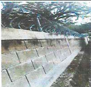
Foto 6 : Instalación de concertina y picos de seguridad en muro perimetral
