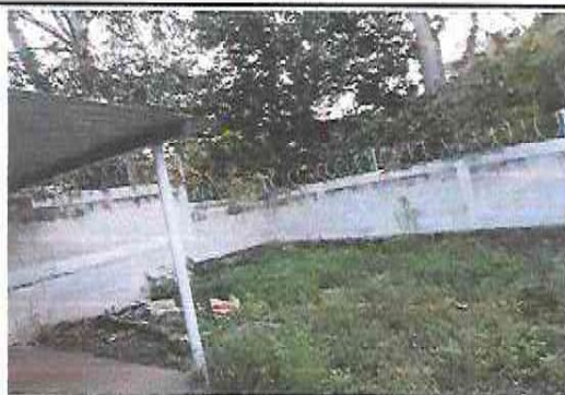
Foto 14 : Instalación de concertina y picos de seguridad en muro perimetral
