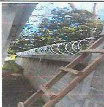
Foto 12 : Instalación de concertina y picos de seguridad en muro perimetral
