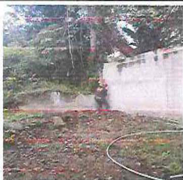
Foto 9: Sustitución de muro perimetral de block
