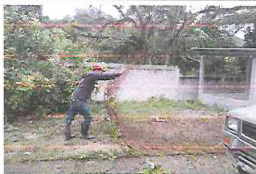
Foto 5: Sustitución de muro perimetral de block
