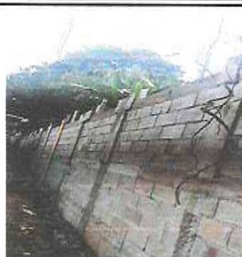
Foto 13 : Instalación de concertina y picos de seguridad en muro perimetral
