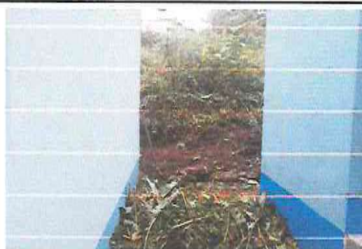
Foto 10 : Sustitución de muro perimetral de block
