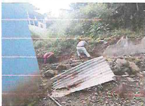
Foto 1 : Sustitución de muro perimetral de block
