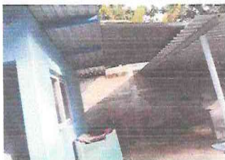
Foto1: Ampliación de estructura de techo de cocina con galera adjunta
