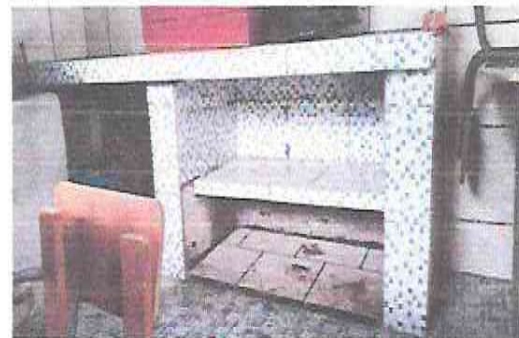
Foto 15: Instalación de puertas para gabinete en el area de cocina
