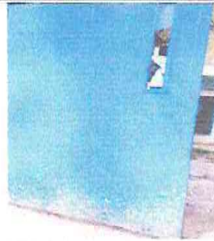
Foto 4: Mantenimiento a estructura de portón de entrada principal (Cambio de cerradura, ampliación y reparación de ventanas dañadas, sustitución de estructura de soporte dañada)
