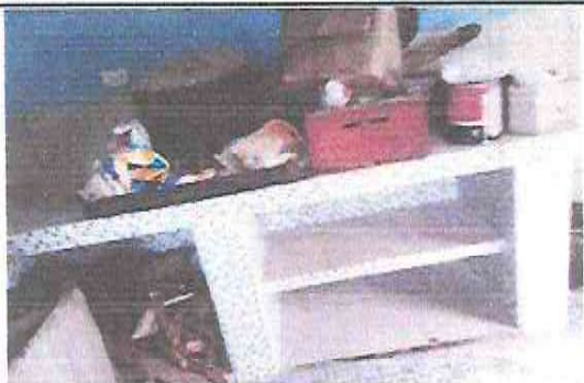
Foto 13: Instalación de puertas para gabinete en el area de cocina
