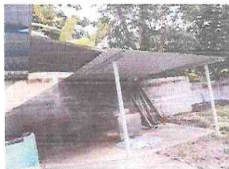
Foto2: Ampliación de estructura de techo de aula con galera adjunta
