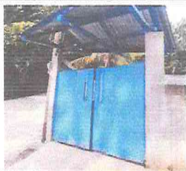
Foto 3: Mantenimiento a estructura de portón de entrada principal (Cambio de cerradura, ampliación y reparación de ventanas dañadas, sustitución de estructura de soporte dañada)
