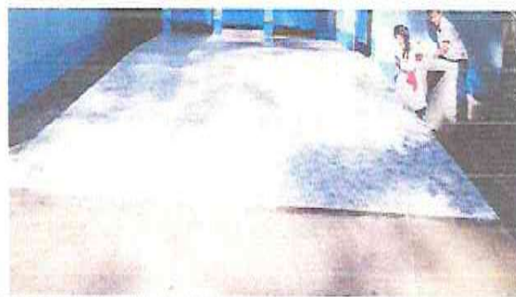
Foto 6: Sustitución de piso de torta de concreto (rustico) por piso cerámico
