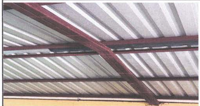
Sustitucion de soporte por metal
