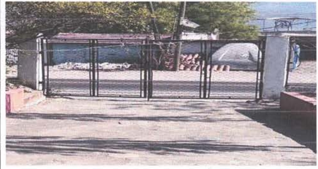
Mantenimiento a portones de metal
