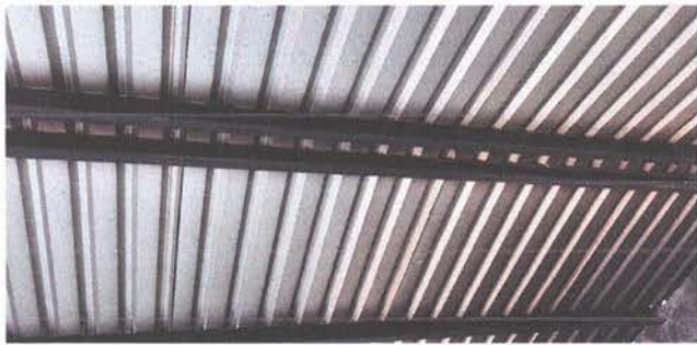
Sustitucion lamina, por lamina troquelada calibre 26
