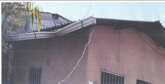
Sustitución de canal de PVC
