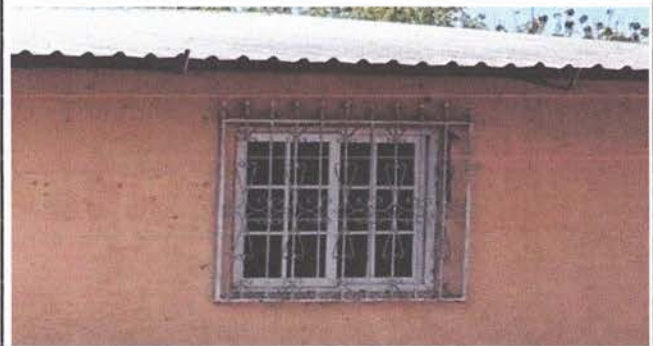
Mantenimiento a estructura de metal de ventana
