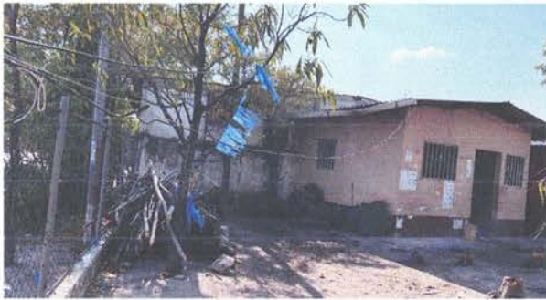
Reparación a sistema electrico
