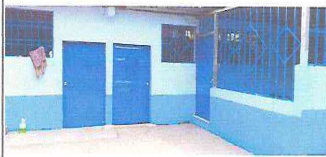
Foto 4: PINTURA EN AULAS EXISTENTES
