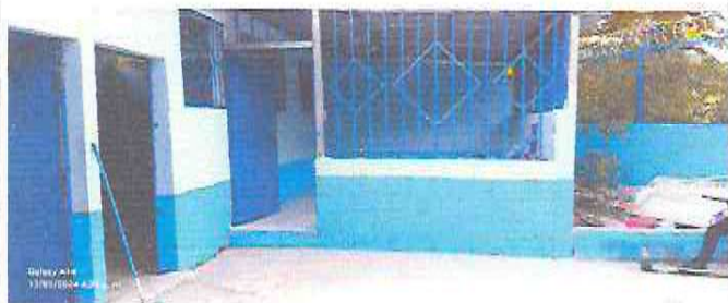
Foto 3: INSTALACION DE PUERTA
