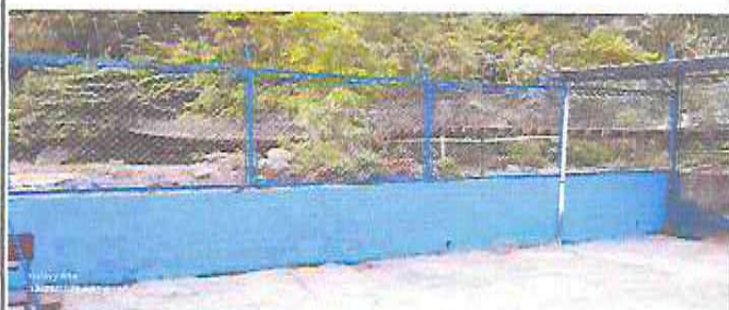
Foto 4: Instalacion de malla en muro perimetral
