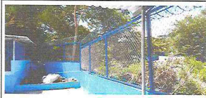
Foto 6: REPARACION DE MURO PERIMETRAL,
