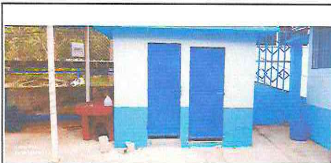
Foto 4: Sustitucion e instalacion de puerta n servicios sanitario
