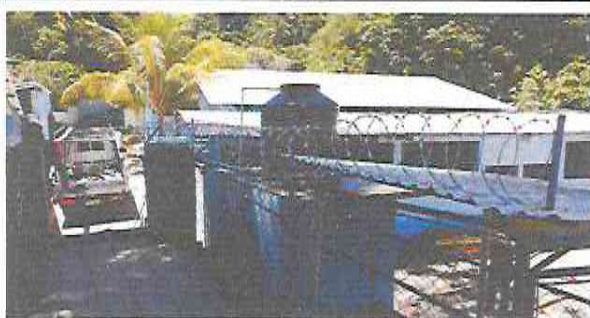
Foto 5: Red de agua potable
