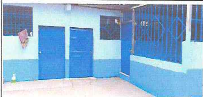
Foto 5: Instalacion de balcones de metal
