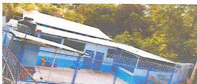
Foto 6: Instalacion de alambre razor ribbon
