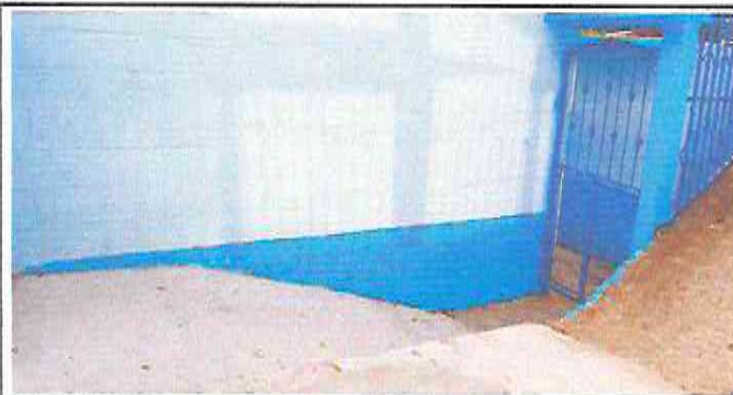
Foto 3: Pintura en muros exteriores e interiores
