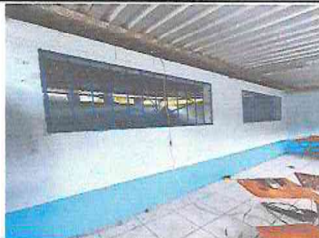
Foto 6: Pintura en muros interiores
