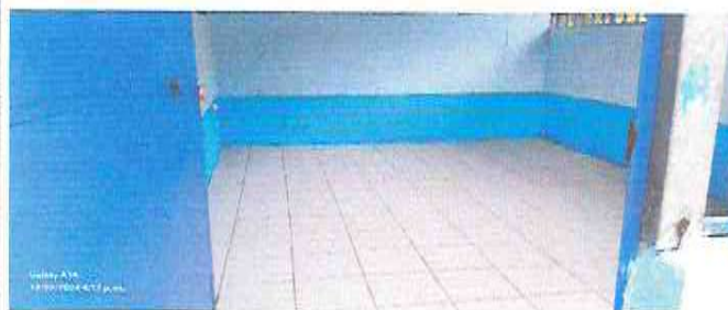
Foto 3: Sustitucion de piso ceramico
