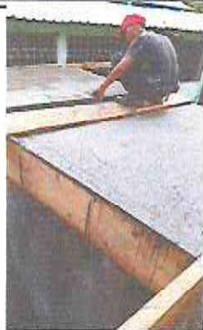
Foto 1: Techo de losa para depósito de agua
