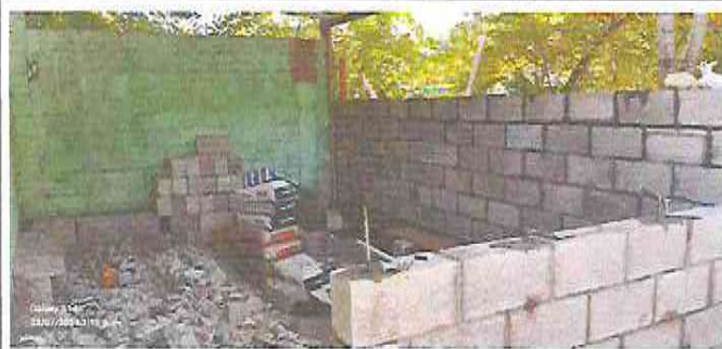
Foto 3: Muro de tabique para aula
