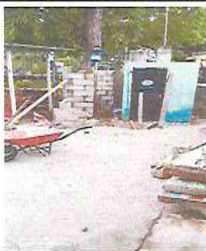
Foto 1: Levantamiento de block para cerramiento
