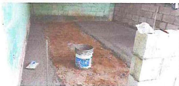
Foto 3: Sustitución de piso de cemento líquido
