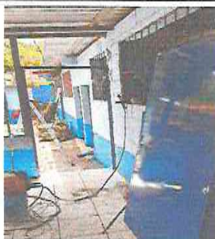
Foto 3: Instalacion de puerta
