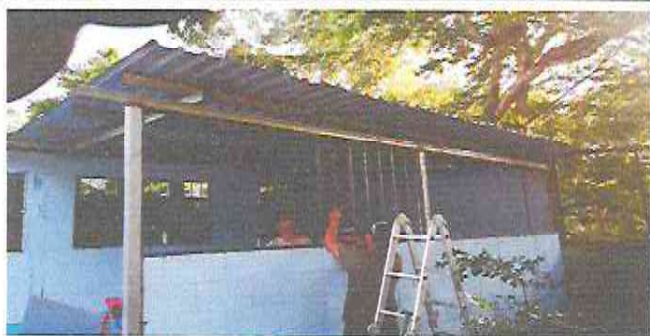
Foto 5: Instalación de balcanes de metal
