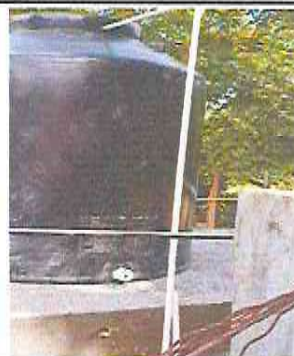
Foto 4: Instalación de Accesorios en depósito de agua existente
