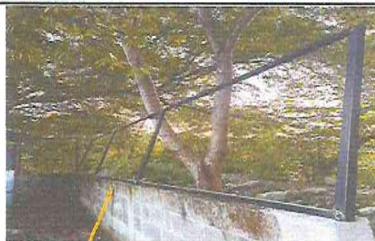
Foto 6: REPARACION DE MURO PERIMETRAL
