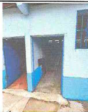
Foto 4: Sustitucion de puertas en aulas existentes
