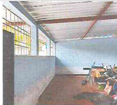
Foto 4: PINTURA EN MUROS INTERIORES Y EXTERIORES
