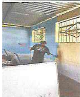
Foto 5: Pintura en muros interiores y exteriores
