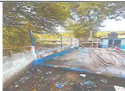
Foto 6: REPARACIÓN DE MURO PERIMETRAL
