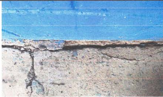
Sustitución de piso de torta de concreto por daños visibles
