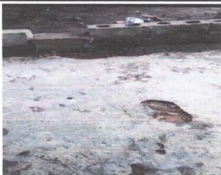
Sustitución de piso de cemento líquido
