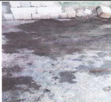
Sustitución de piso de torta de concreto
