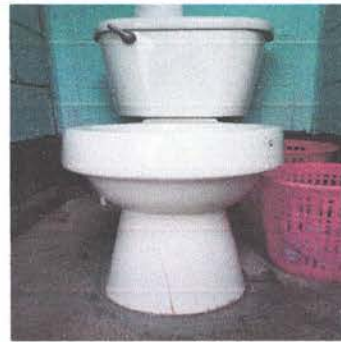
SUSTITUCIÓN DE INODORO
