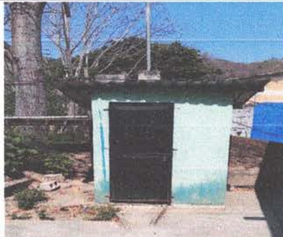
Sustitución de puerta en servicios sanitarios
