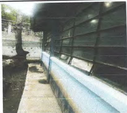
Foto 1: Sustitución de ventanas de vidrio y metal por ventanas de PVC corredizas con vidrio de 5mm de grosor
