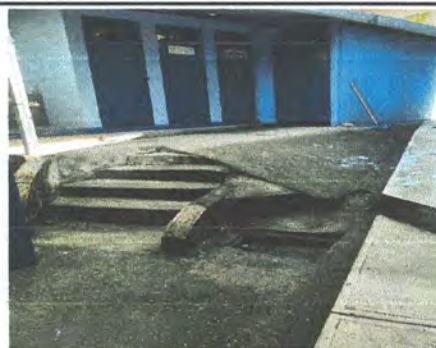
Foto 6: Reparación de gradas de acceso hacia los baños
