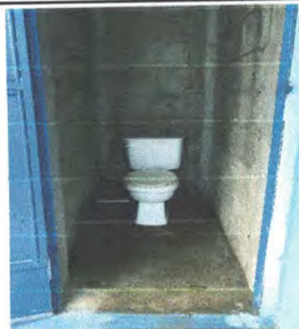
Foto 2: Sustitución de sanitario con sus accesorios
