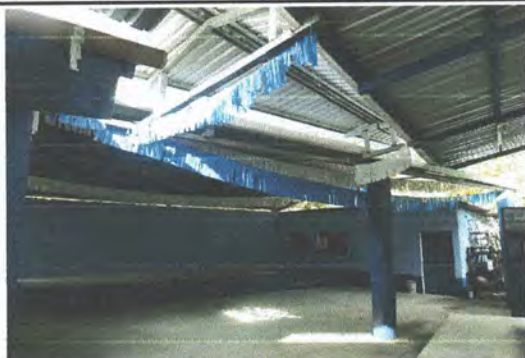
Foto 3: Sustitución de canal de bajada de agua pluvial de plástico por canal de metal de lámina troquelada calibre 26
