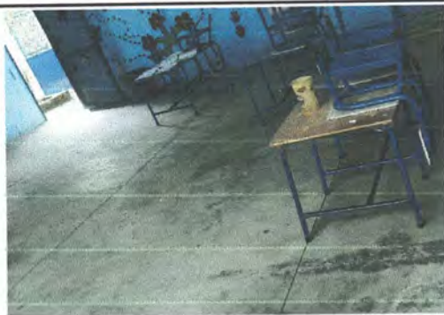
Foto 9: Sustitución de piso de torta de concreto dañada por piso cerámico
