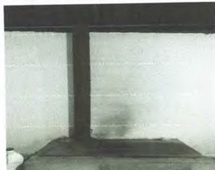
Foto 15: Sustitución de estufa rural completa (Incluye polletón, plancha de metal y chimenea)
