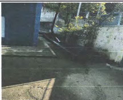
Foto 5: Reparación de arriate de block (Incluye repello, cernido y pintado)
