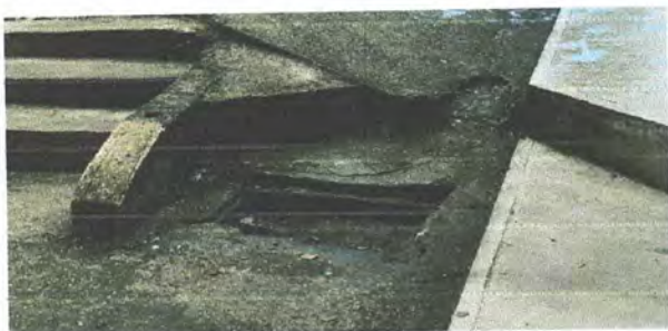
Foto 13: Sustitución de caja de registro que conecta al alcantarillado
