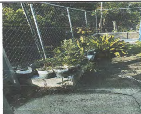
Foto 4: Reparación de arriate de block (Incluye repello, cernido y pintado)
