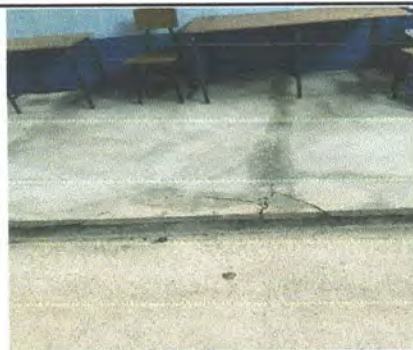
Foto 12: Sustitución de piso de torta de concreto dañada por piso cerámico
