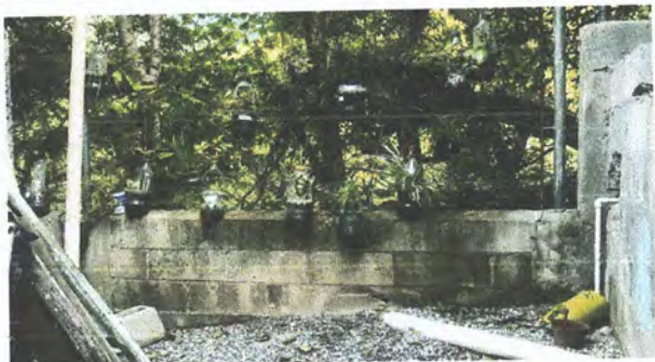
Foto 7: Reparación de muro perimetral de block, tubo hg y malla galvanizada
