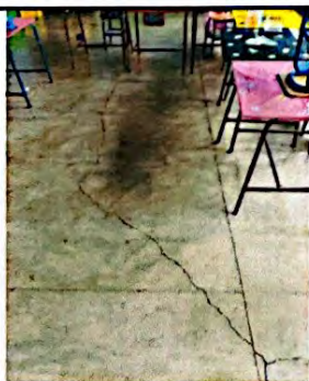
Foto 5: Reparación de Piso en Aula. Sustitución de piso de concreto a piso cerámico y Pintura general en Aulas.
