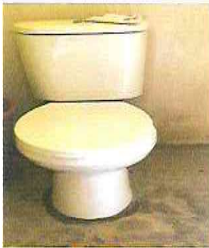
Foto 3: Sustitución de inodoro, incluye accesorios e instalación.
