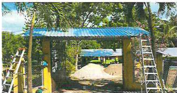
Foto 1: Reposición de estructura de techo en entrada de escuela.
