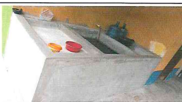
Foto 6: Sustitución de área de cocina (pila)
