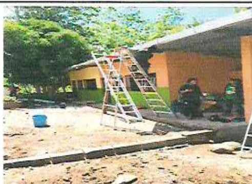
Foto 4: Instalación de canales.
