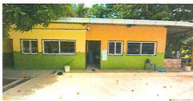
Foto 2: Instalación de ventanas corredizas de pvc
