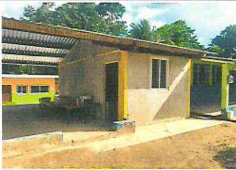
Foto 7: Tratamiento de grietas de paredes
