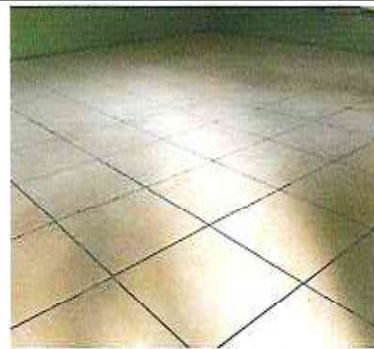
Foto 2: Instalación de piso cerámico.
