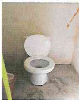
Foto 3: Sustitución de inodoro, incluye accesorios e instalación.
