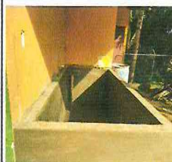
Foto 6: Sustitución de área de cocina (pila)
