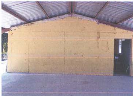
Foto 6: Reparación de paredes y cernido de paredes.
