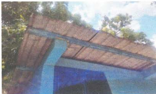
ESTRUCTURA DE TECHO
