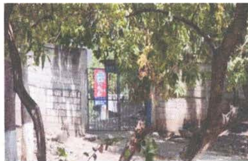
SUSTITUCIÓN DE PORTON
