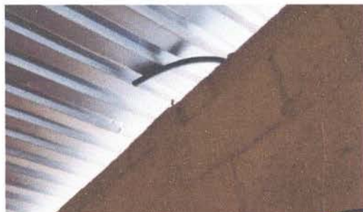
REPARACIÓN DE SISTEMA ELÉCTRICO
