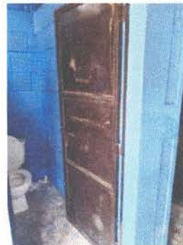
SUSTITUCIÓN DE PUERTA DE SANITARIOS
