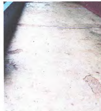
Sustitución de piso de torta de concreto
