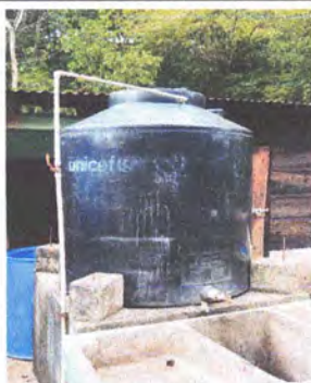
Sustitución de depósito de agua de 1100 Lt.
