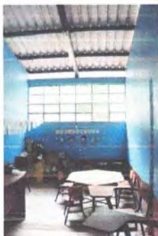
Mantenimiento a estructura de metal de ventana
