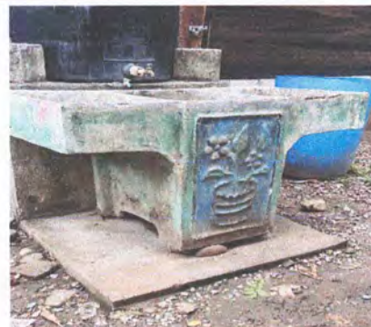
Sustitución de pila de concreto de 2 lavaderos
