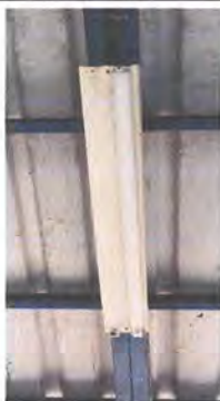
Sustitución de lámparas de tubo
