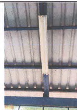
Sustitución de lámina troquelada por lámina troquelada aluzinc calibre 26
