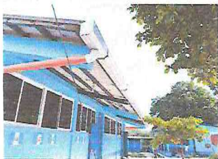
Foto 1: Instalación de ventanas corredizas en PVC
