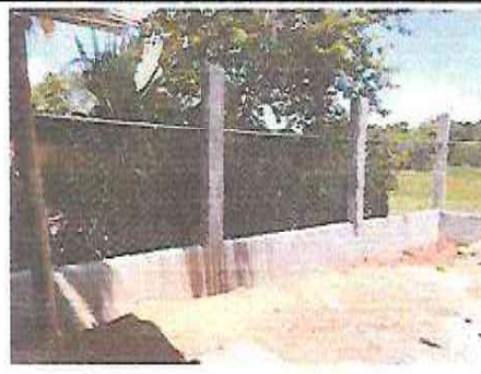
Foto 6: Cambio del muro perimetral
