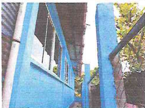
Foto 3: Pinturas en paredes y muros
