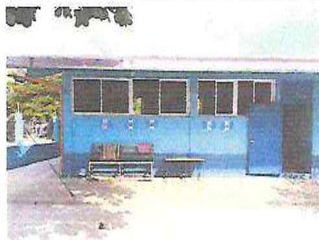
Foto 4: Pinturas en paredes y muros
