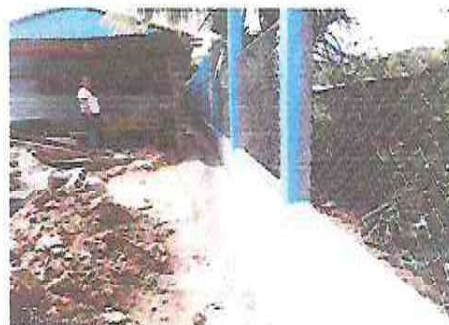
Foto 2: Cunetas parte posterior de aulas de párvulos
