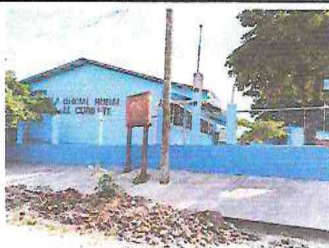
Foto 3: Pinturas en paredes y muros
