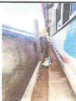
Foto 5: Cambio del muro perimetral
