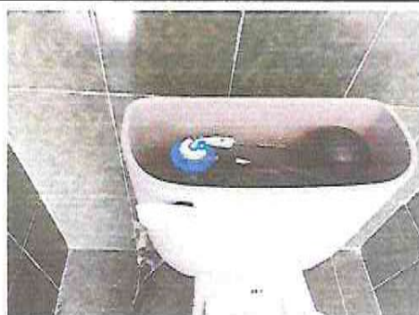
Foto 4: Cambio de baño y accesorios
