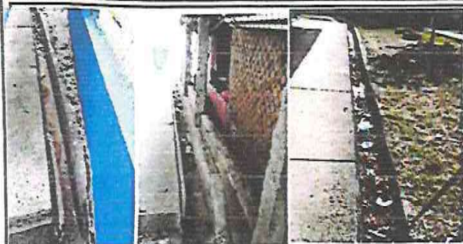
Foto 6: Reparación de cunetas de parte frontal de las aulas.
