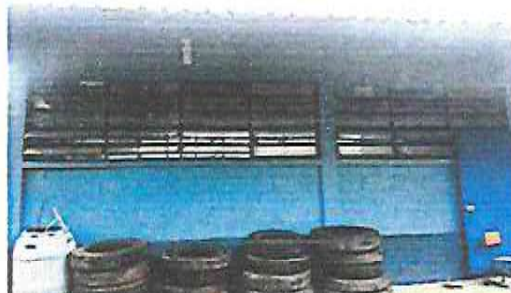
Foto 2: Suministros de ventas corredizas de tubo PVC
