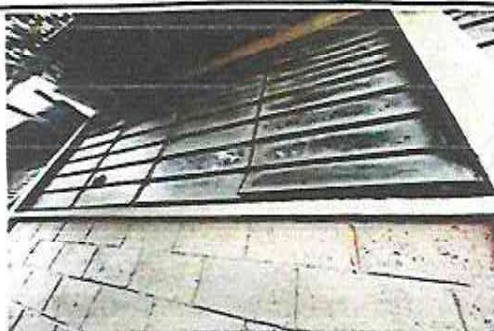
Foto 3: Suministros de ventas corredizas de tubo PVC
