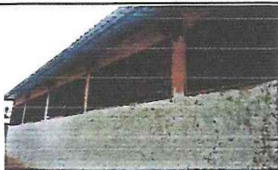
Foto 8: Pintura en muro de aulas interiores y exteriores.
