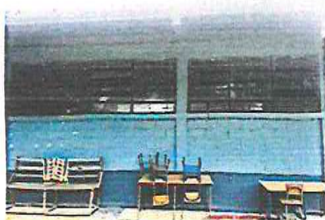
Foto1: Pintura en muros de interiores y exteriores
