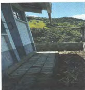
Foto 3: Reparación de banquetas de concreto
