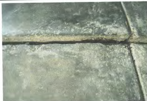
Foto 17: Sustrución de piso de torta de concreto por piso cerámico en el área del aula
