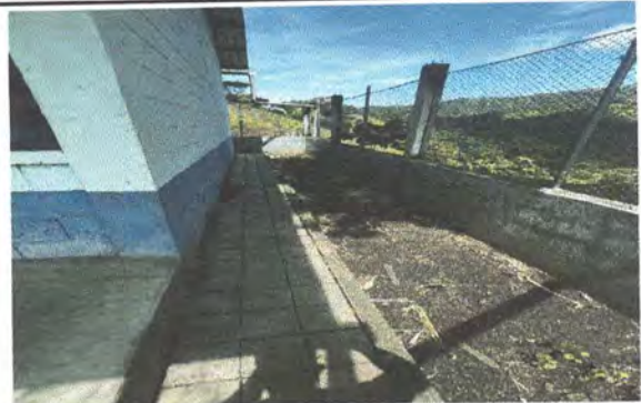
Foto 10: Reparación de banquetas de concreto
