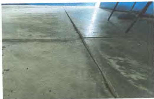
Foto 18: Sustrución de piso de torta de concreto por piso cerámico en el área del aula
