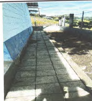
Foto 2: Reparación de banquetas de concreto
