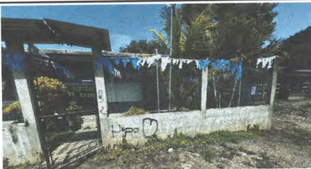
Foto 11: Repello, cernido y pintado en muro perimetral
