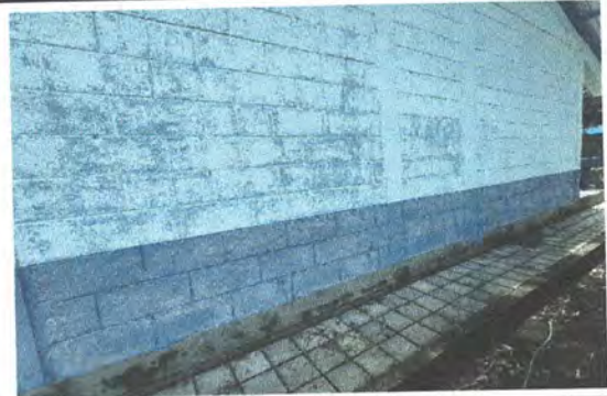
Foto 8: Pintura en muros exteriores e interiores
