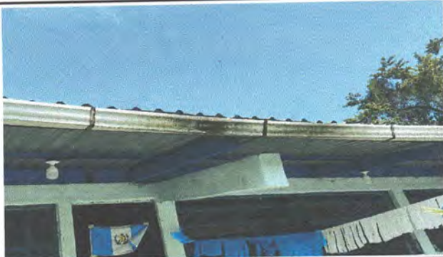
Foto 9: Sustitución de canal de pvc y sustitución de soporte
