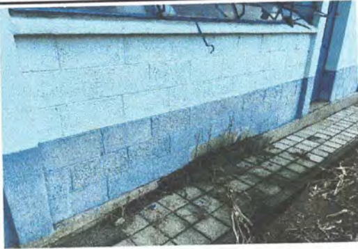
Foto 7: Pintura en muros exteriores e interiores
