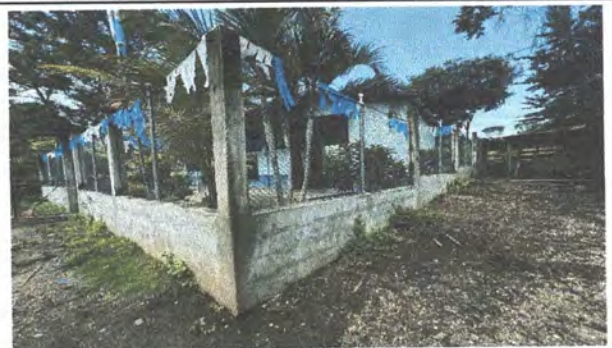
Foto 12: Repello, cernido y pintado en muro perimetral
