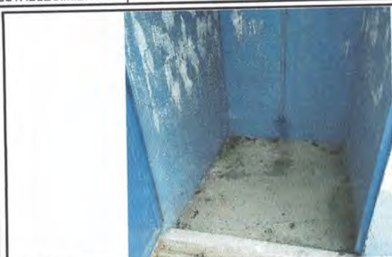
Foto 13: Reparación o instalación de azulejo en el área de la ducha y sustitución de reposadera
