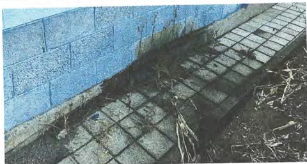
Foto 1: Reparación de banquetas de concreto
