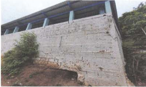
REPELLO EN MURO PERIMETRAL
