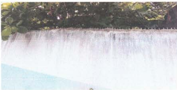
PINTURA EN MUROS
