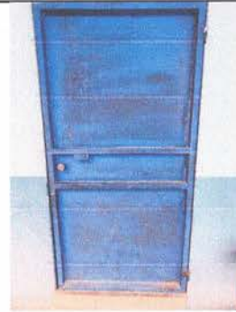
SUSTITUCIÓN DE PUERTA DE METAL
