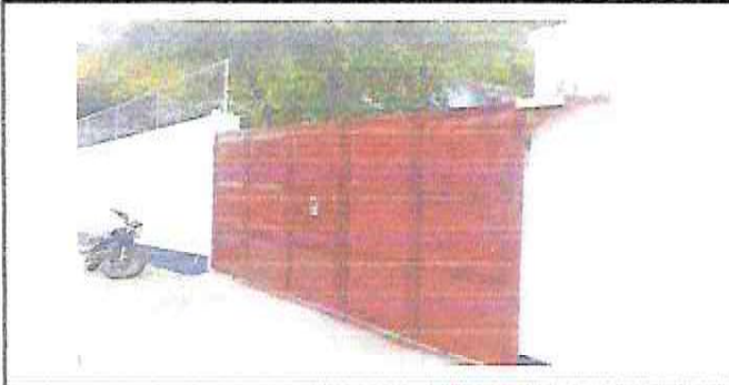
Foto 1: Sustrucción de portón de metal 5.10m de largo 2.30m de alto
