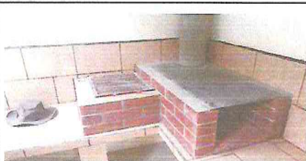
Foto 5: Sustrucción de estufa rural ( completa) incluye polletón, chimenea y plancha de metal.
