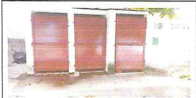
Foto 4: Mantenimiento a estructura (lijado, cepillado, sujeciones, aplicación de pintura) a puertas de servicio sanitario.
