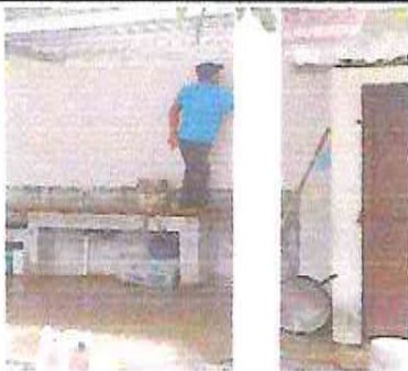
Foto 9: Sustrucción de soporte de madera por concreto.
