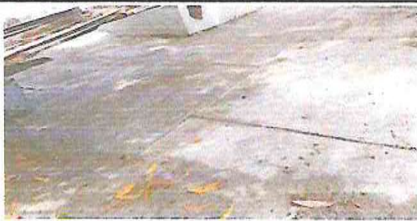
Foto 3: Sustrucción de línea principal 120 metros lineales más accesorias.
