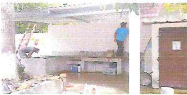
Foto 7: Sustrucción de lámina por lámina troquelada aluzinc calibre 26.
