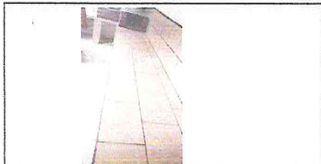
Foto 6: Instalación de azulejo en estufa rural.
